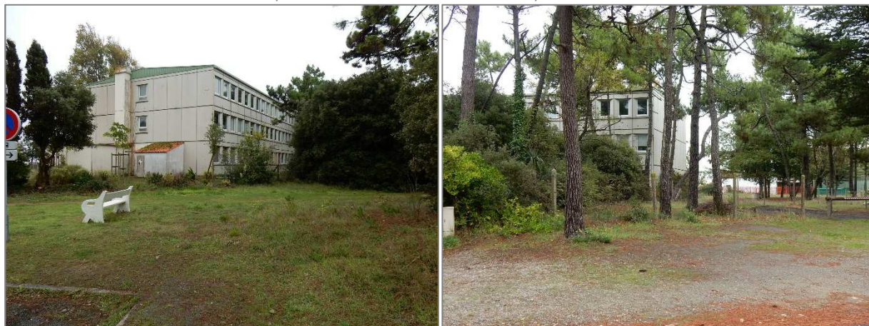
Le bâtiment de l'ancienne école vu depuis la rue des Moulins et la rue des Sports
